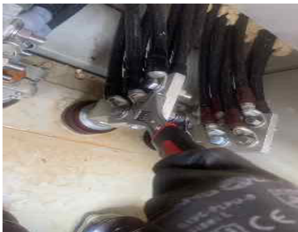
ชั้นอัดข้อต่อสายไฟฟ้าด้านแรงต่ำ
